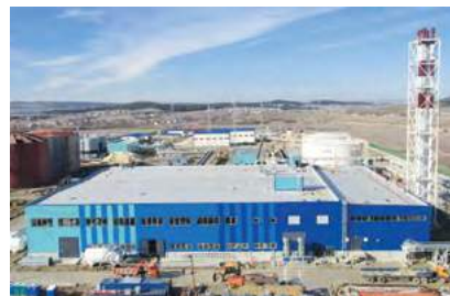
Пункты распределительные ПГУ-ТЭС г. Севастополь
