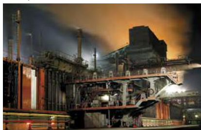
Подстанция 110/10 кВ, «Коксующий уголь» Кемеровская область, «Кокс Майнинг»
