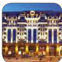
Защита высотных домов и гостиничных комплексов
