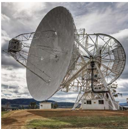
Системы управления и телекоммуникации
