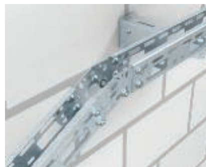
Вертикальное продольное соединение Вертикальное угловое соединение мини-каналов AZ с помощью 2-х соединителей VF AZK.
