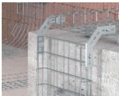
Готовый монтаж Установленный С-образный проволочный лоток.
