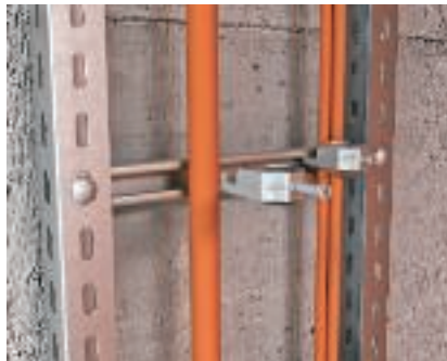
Крепление провода с помощью зажимной скобы Крепление провода на перекладине с помощью зажимных скоб.
