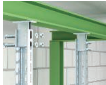
Монтаж траверсы Монтаж траверсы KU 7 AOX для приваривания к стальным балкам.
