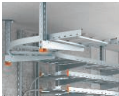
Готовый монтаж Установленный кабельный лоток лестничного типа.
