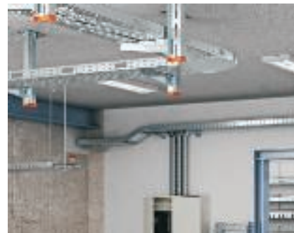
Комплексный монтаж потолочного крепления Потолочный монтаж кабельных лотков.
