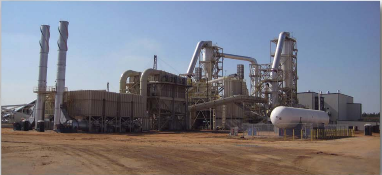
Завод по производству древесных пеллет, Флорида
