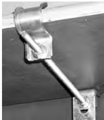
Примеры использования зацепок двутавра ZDW с полосой
